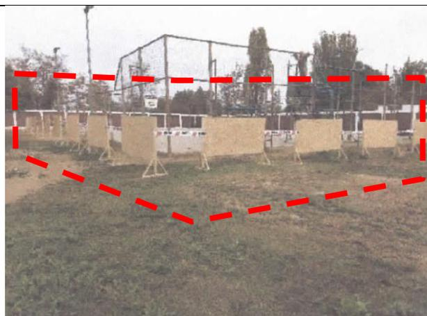
Fotografía N°14: Imagen contenida en la página 17, del expediente de antecedentes, del estado de pago N°1, del contrato, para la partida 1.3. "Cierros". Muestra paneles móviles de madera.
