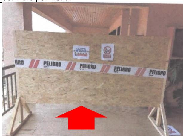
Fotografía N°13: Imagen contenida en la página 17, del expediente de antecedentes, del estado de pago N°1, del contrato, para la partida 1.3. "Cierros". Muestra un panel móvil de madera.
