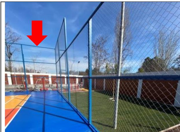
Fotografía N°11: Altura del cierre inferior, al doble del muro perimetral.
